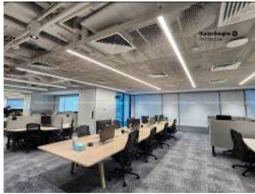
Gambar 4. Penggunaan AC Central pada Ruangannya Capital Tower Singapura (Sumber: Capitaland, 2023).
