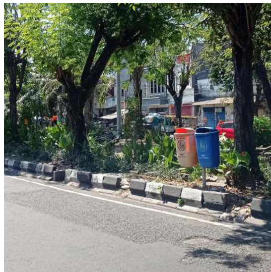
Gambar 6. Tempat sampah pada area pedestrian (Sumber: dokumentasi pribadi,2023)
