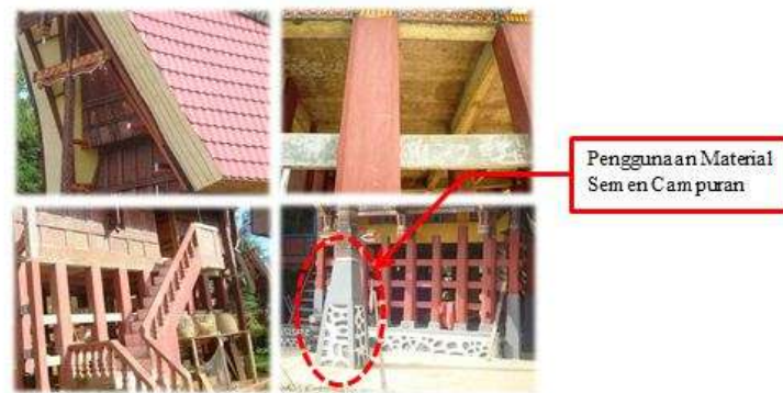
Gambar 6. Gambar Pondasi Rumah Tongkonan (Sumber: Sosbud Kompasiana, 2015)
