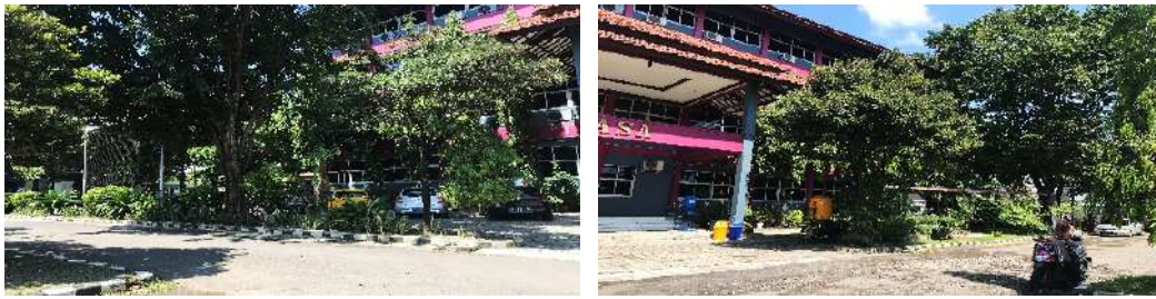
Gambar 3. Perkerasan Jalan Bagian Utara Gedung FAD (Sumber: dokumentasi pribadi, 2022)
